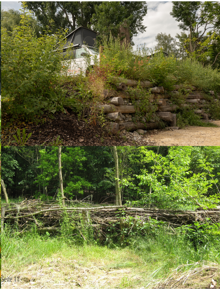
oben: Krainerwand auf Naturcampingplatz Mainau-Litzelstetten, unten: Benjeshecke
